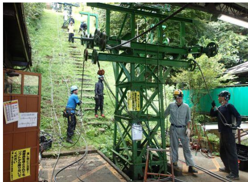
鋼索交換作業
