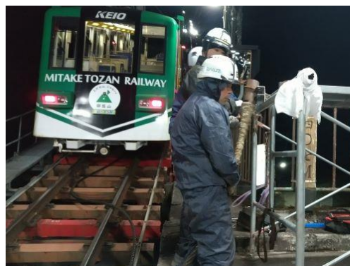
鋼索切詰作業
