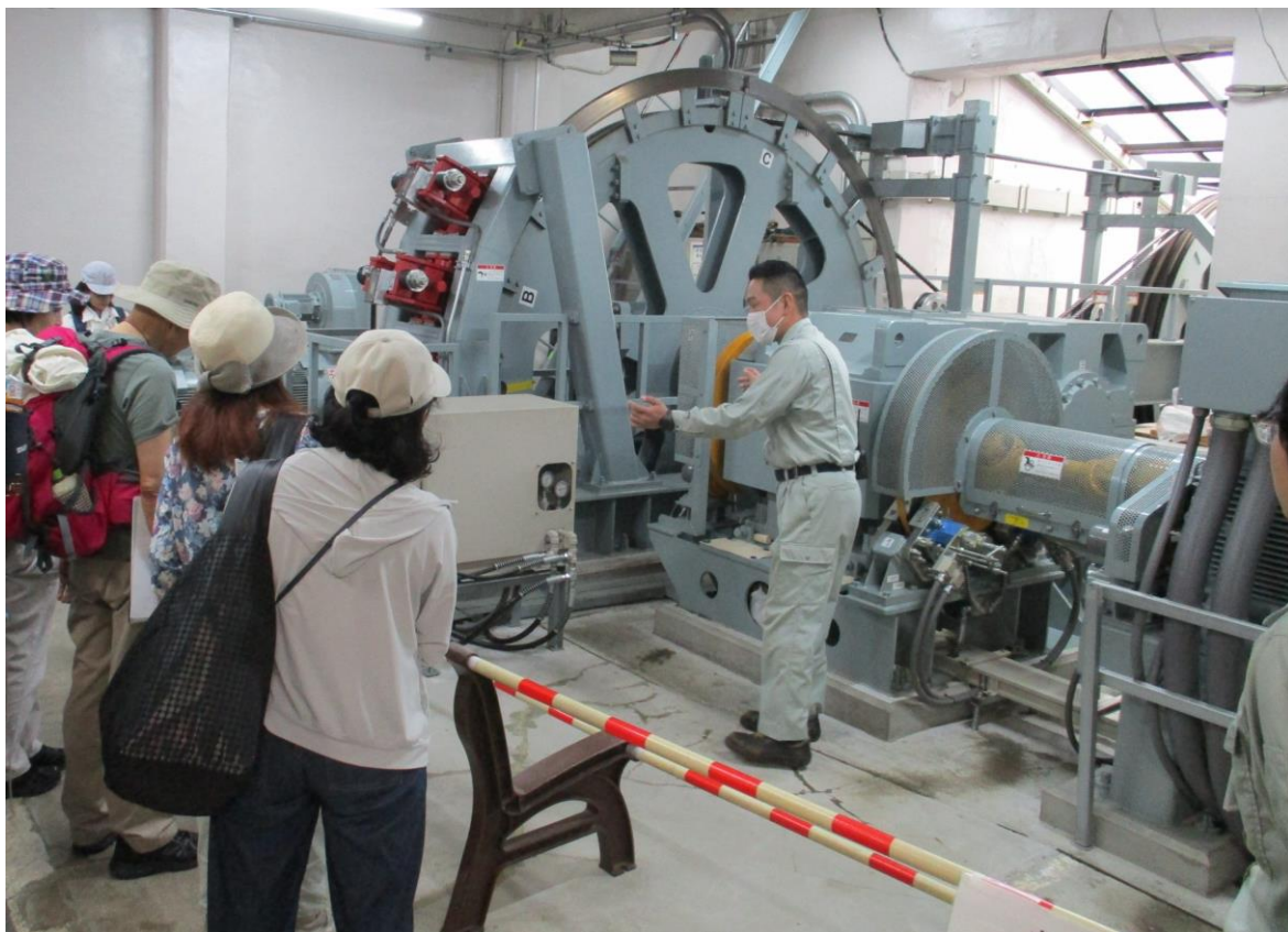
ケーブルカーの裏側見学の様子
