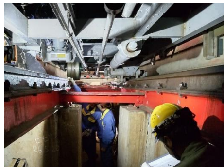
車両油圧ポンプ交換工事
