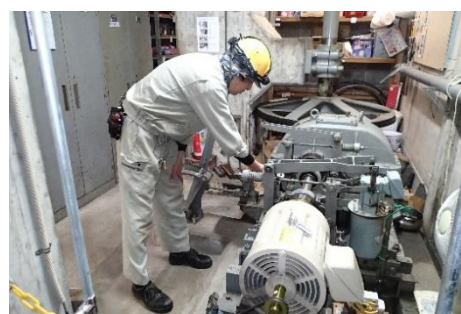
リフト減速機点検
