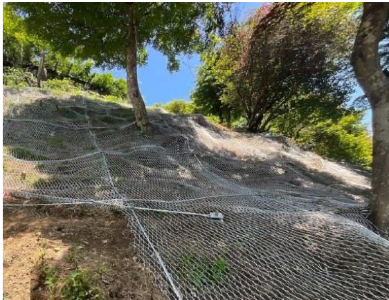
ロープ伏せ工法による御岳山駅北斜面土砂流出対策工事
