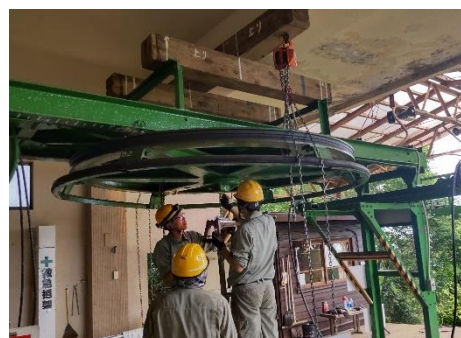
オーバーホール作業
