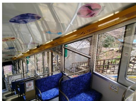
車両照明 LED 化修理
