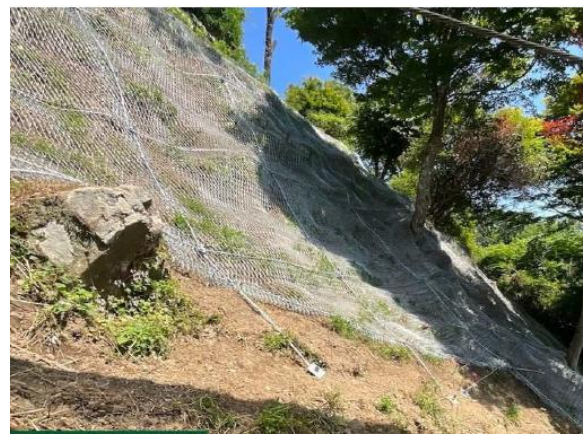
ロープ伏せ工法による御岳山駅北斜面土砂流出対策工事
