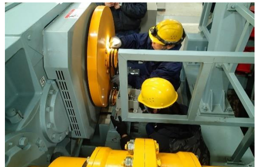
遠心カススイッチ交換工事
