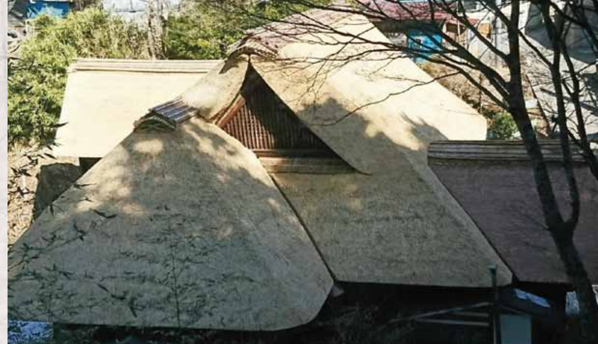
2018年4月修理工事が終了した東京都指定有形文化財(建造物)の馬場家御師住宅
